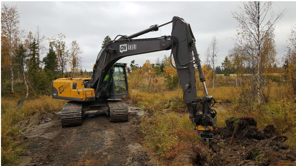
Plöjning av fiber mellan Selet och Jämtland.
