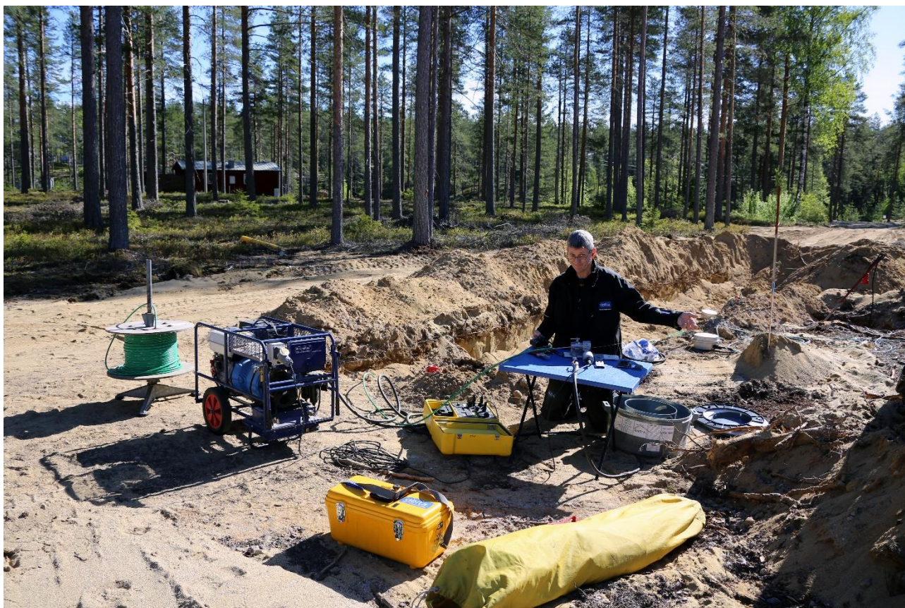
Robert från Delta AB klarar av det mesta i bredbandsväg och är en viktig person för att vårt bredbandsnät ska fungera. Här handlar det om en reparation i Dannebo, Haddingen.
