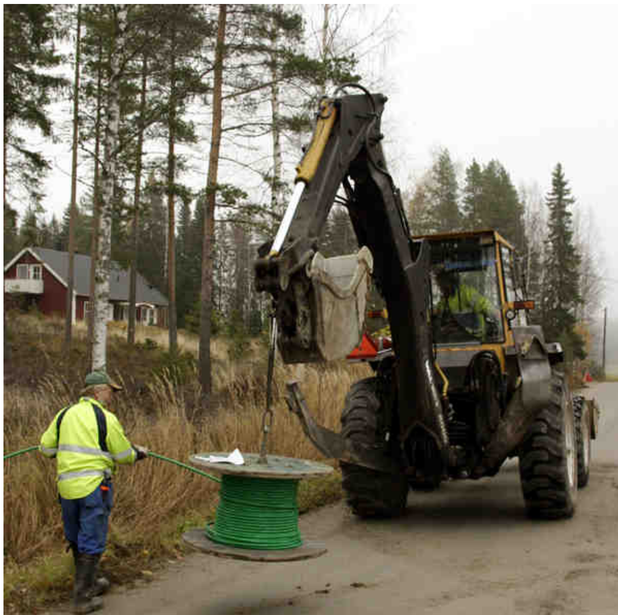
Att bygga bredband innebär ofta att ta sig fram och dra ut en väldans massa fiber eller kanalisationsrör. Här är det Sune Karlsson, med medarbetaren Johnny, som slingar ut i Långviken i samband med en tillkommande anslutning.
