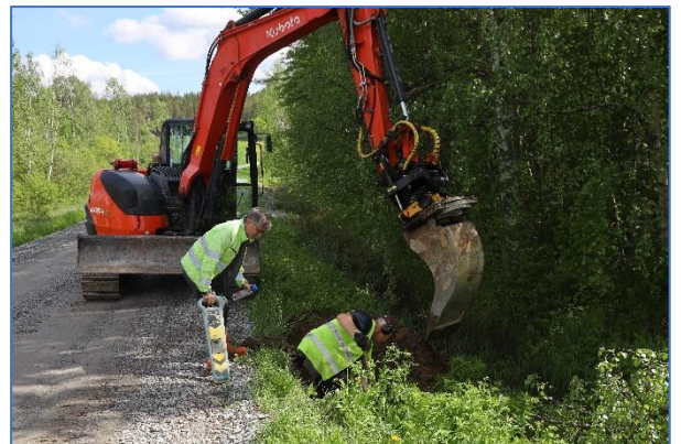
Per-Gunnar Olofsson och Sune Karlsson vid lagning av skada vid Lilla Amerika, Avalidenvägen.
