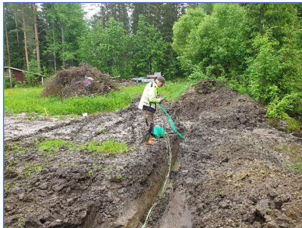
Under ett år sker det olika saker i vårt nät. Och då ska det fixas. Här är det Roland Johansson som ser till att en avgrävning blir lagad i Hjuksbäck.
