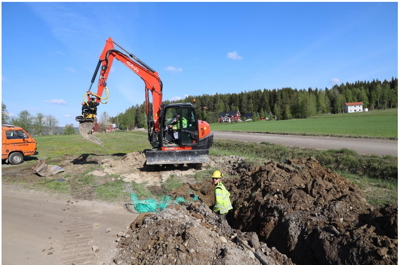
Sune Karlsson från Mickelträsk ser till att fiberkabeln förläggs på ett tryggt sätt. Sebastian Dahl assisterar.
