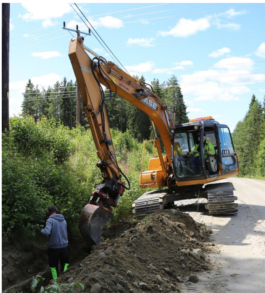
Omförläggning av fiberkabel av mellan Snålltjärn och Tväråbäck.
